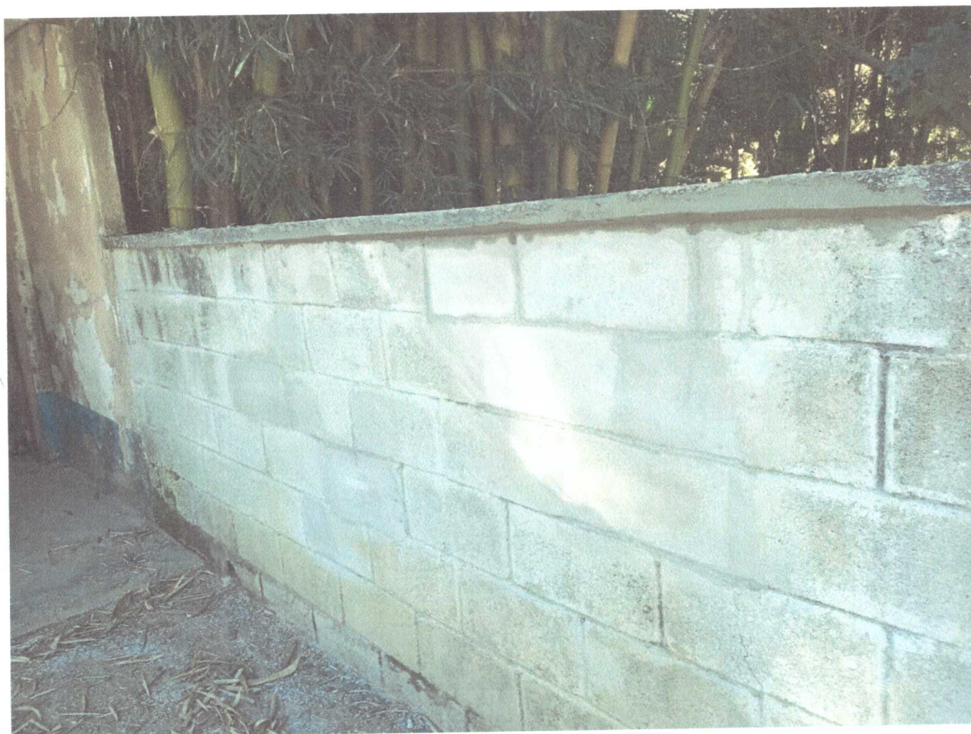
ASSENTAMENTO DE BLOCO DE CONCRETO
