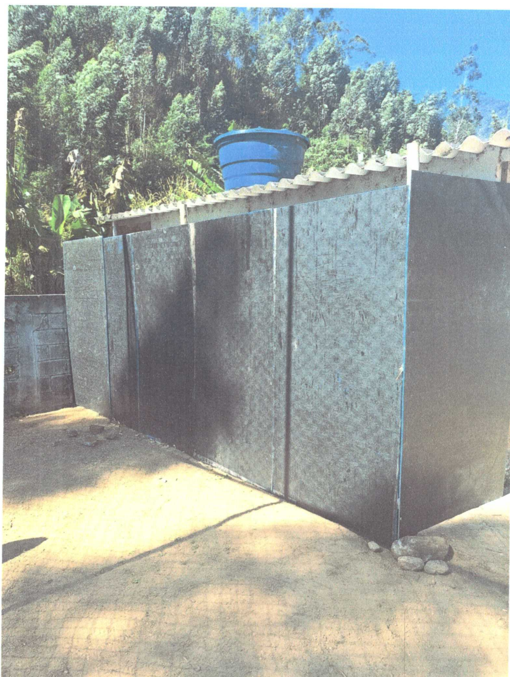
EXECUÇÃO DE SANITÁRIO E VESTIÁRIO NO CANTIERIO DE OBRA
