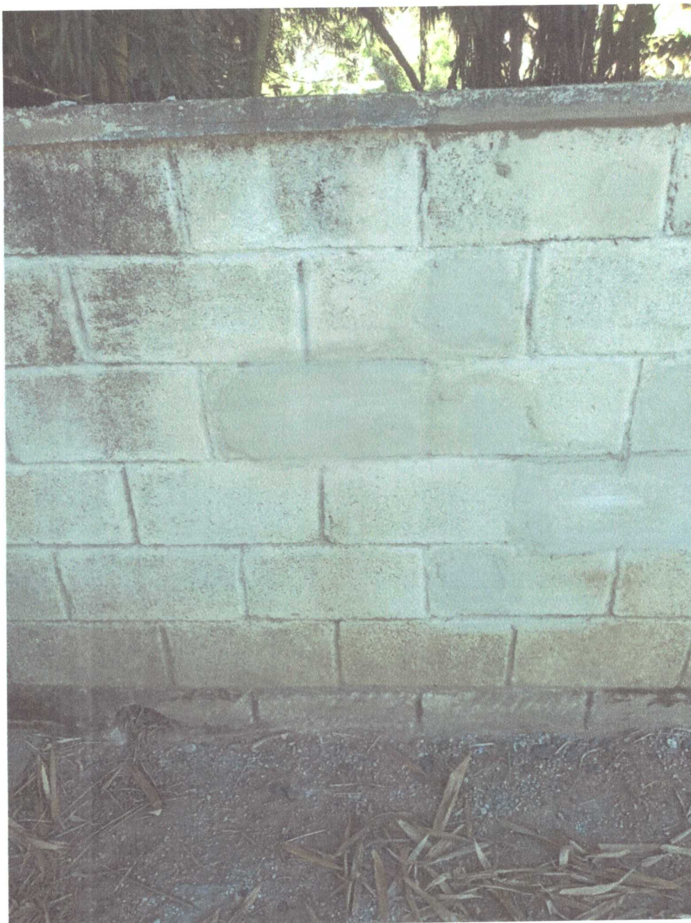
ASSENTAMENTO DE BLOCO DE CONCRETO
