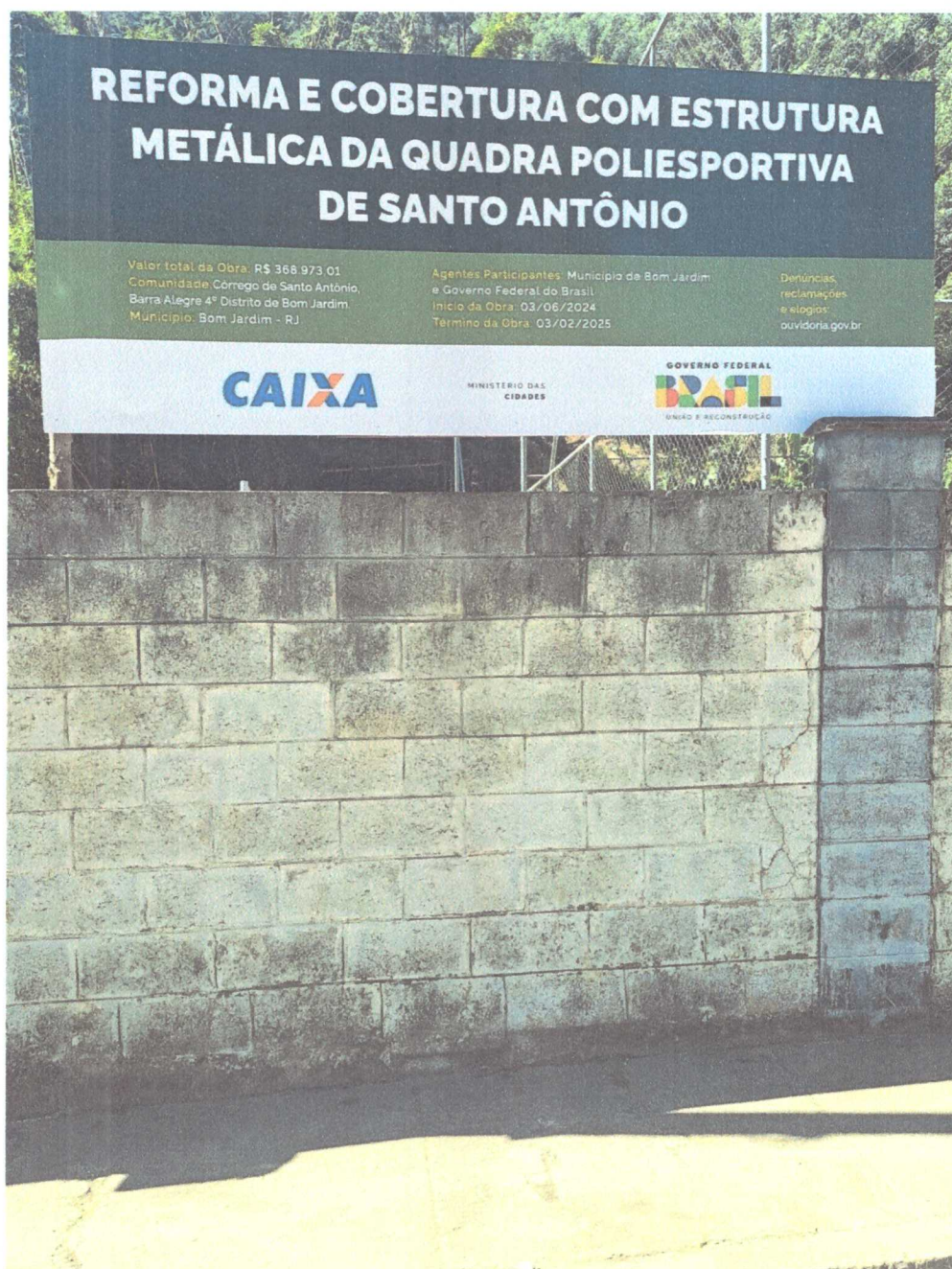
CONFEÇÃO DE PLACA DE OBRA
